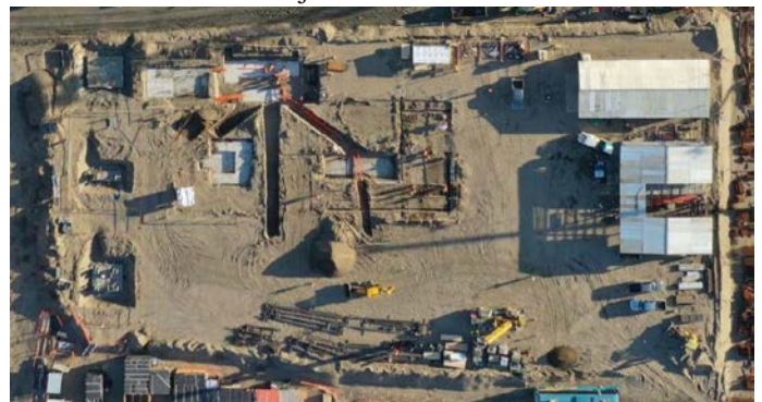
Figura 1: Foto aérea de la plataforma de la obra
