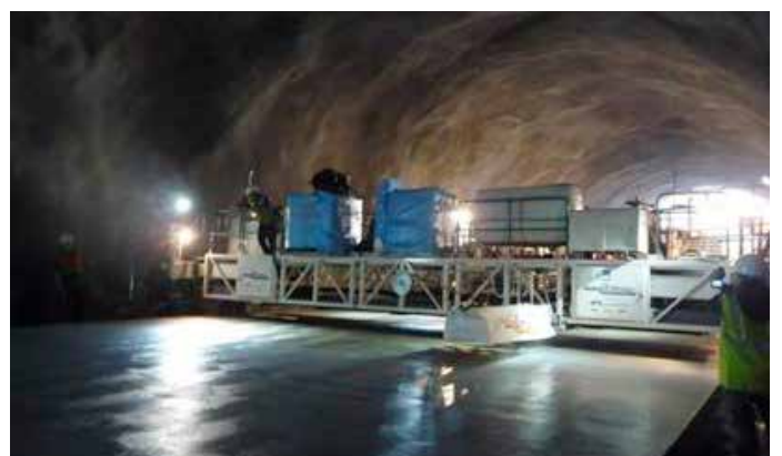
Figura 3: Ejecución del pavimento de hormigón en un túnel
