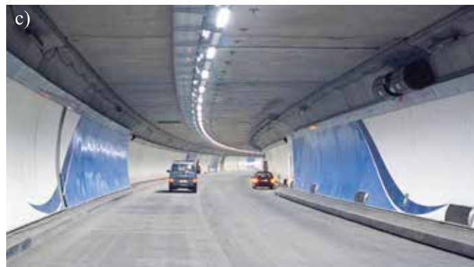
Figura 1: Túnel de Cointe (Lieja, Bélgica), abierto al tráfico el 2 de junio de 2000. Unidireccional, longitud 1639 m, sección 116 m 2 . a) Sección del túnel, b) ejecución de un pavimento de hormigón armado continuo y c) pavimento de hormigón armado continuo (Routes 83, 2003)
