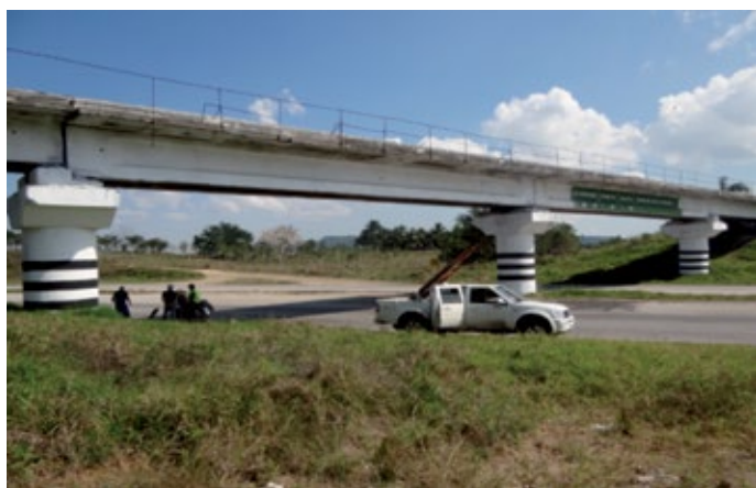
Figura 1: Puente de la Autopista Habana-Pinar
