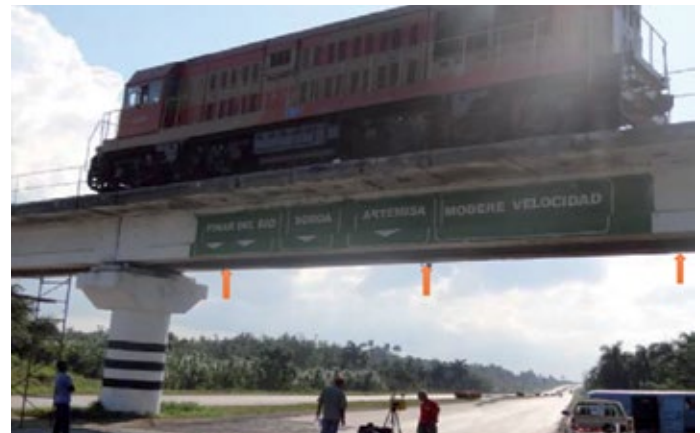
Figura 6: Aplicación de prueba de carga estática (↑ puntos controlados)
