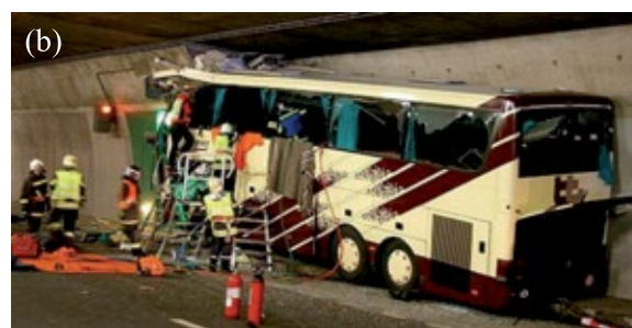
Figura 12: Túnel de Sierre, Suiza, a) vista de las bocas y b) accidente con colisión de un autobús con el final de un apartadero (fuente: Excite Network)
