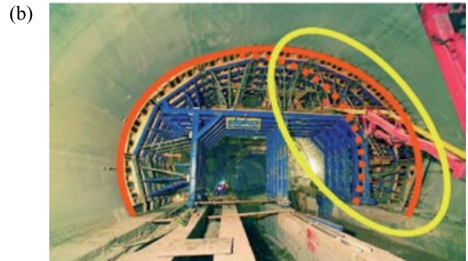
Figura 3: a) Encofrado para los apartaderos y b) túnel de Javorova, autopista A-6, Croacia (DOKA, 2007)
