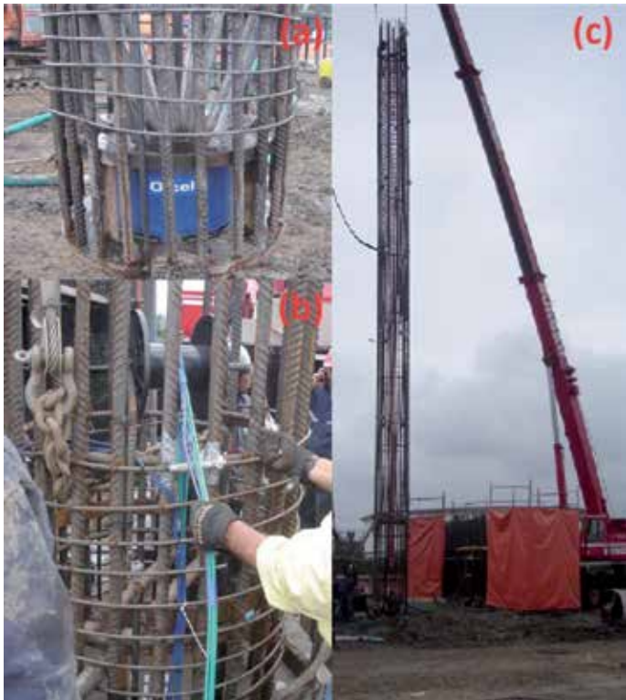
Figura 3: a) Celda Osterberg instalada en parte inferior de la armadura, b) cables para operar la celda desde la superficie y c) izaje de uno de los cuerpo de armadura para instalarlo en la perforación (Pilotes Terratest, 2006b)
