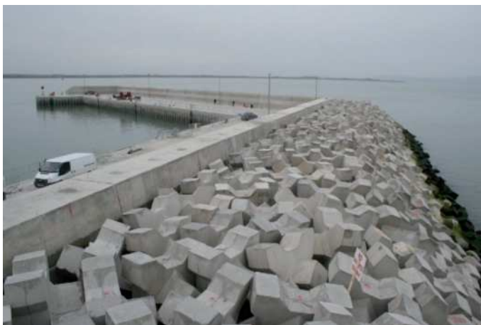
Figura 1: Dique con espaldón en Oriel, Irlanda
