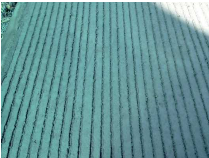
Figura 13: Inspección visual prueba piloto
