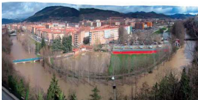
Figura 2: Fotos de las inundaciones del 12 de febrero de 2009 en Pamplona
