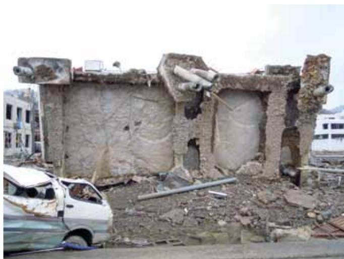
Figura 2: Edificio de hormigón armado fundado sobre pilotes volcado por el tsunami en Onagawa
