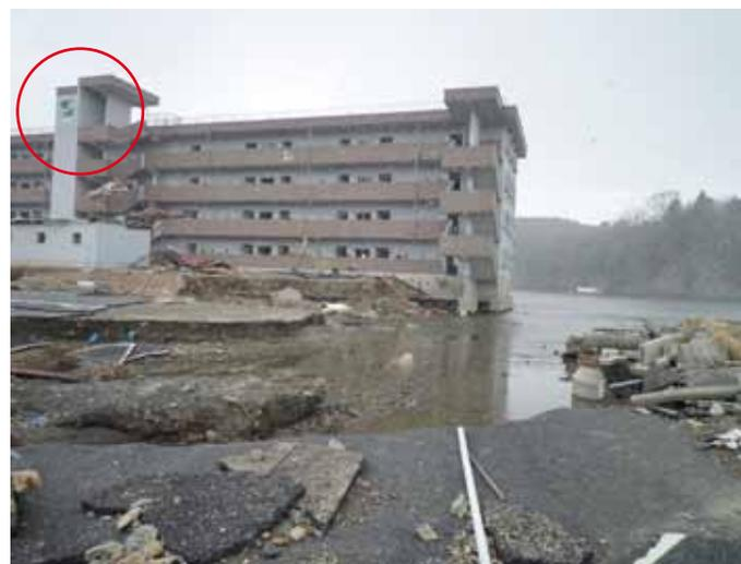
Figura 3: Edificio de evacuación (círculo rojo) de Minamisanriku con accesos socavados
