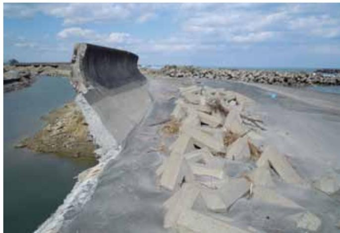
Figura 5: Ruptura de las estructuras de defensa en Watari. La socavación de la parte posterior del dique deja expuesto el núcleo de arena a la acción del agua, lo cual eventualmente también resultó en la rotura de la parte frontal del dique construida de hormigón.
