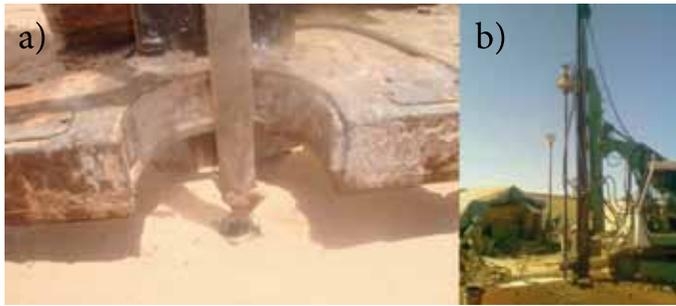
Figura 1: a) Punta y tubo de refuerzo autoperforante para micropilote Anker y b) máquina de perforación
