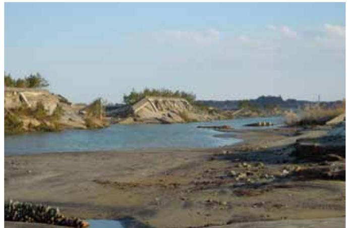
Figura 4: Colapso de una estructura de protección en la ciudad de Soma (Prefectura de Fukushima). Las partes de la estructura que sobrevivieron estaban reforzadas con tetrápodos colocados delante de ellos.
