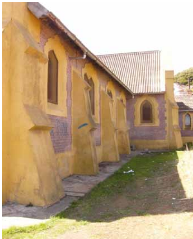
Figura 4. Vista lateral de la estructura con contrafuertes
