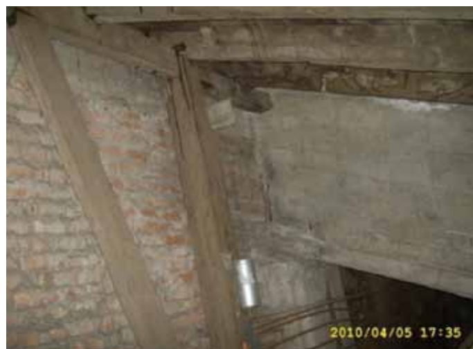
Figura 3: Detalle de la estructura de techumbre de iglesia La Pompeya
