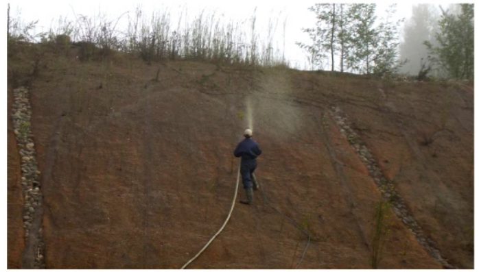
Foto 6: Aplicación de una hidrosiembra en un talud de 70°
