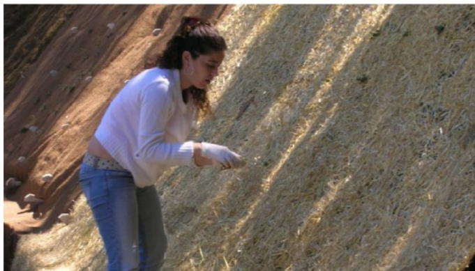
Foto 17: Plantación de inulas sobre biomantos de fibra de paja.
