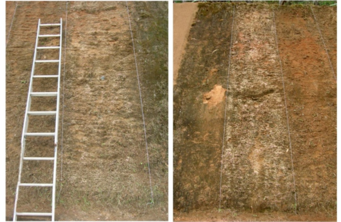
Foto 13: Franjas horizontales cubiertas con semillas
