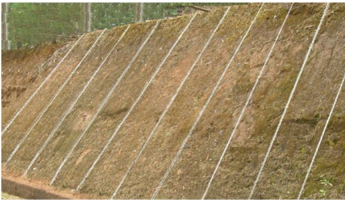
Foto 8: Talud en estudio
