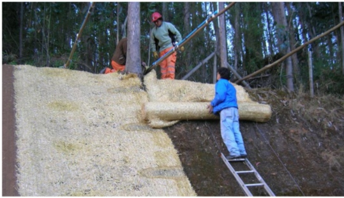
Foto 15: Instalación de fibra de paja
