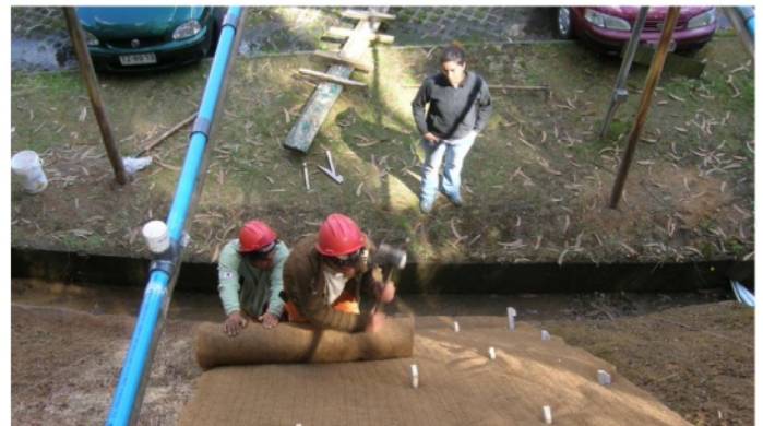
Foto 14: Instalación de fibra de coco
