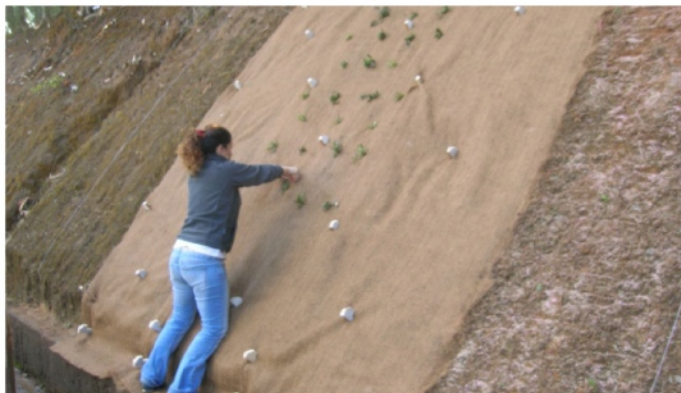
Foto 16: Plantación de inulas sobre biomantos de fibra de coco.
