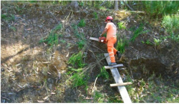
Foto 7: Limpieza del talud
