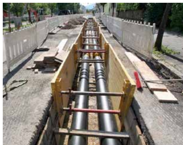
Figura 3: a) Tuberías de calefacción distrital, b) instalación en una zanja en el suelo mostrando uniones de tuberías y c) vista general de la instalación en medio de la ciudad
