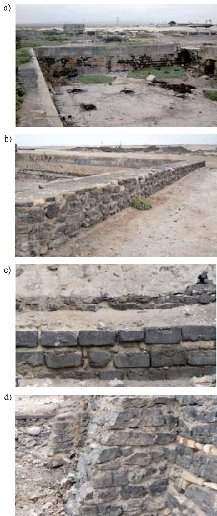
Figura 5: Zona 1: a) vista del interior, b) murete exterior con fragmentos de escoria de cobre, c) cimiento de bloques de escoria y d) muro exterior de escoria de cobre con contrafuertes
