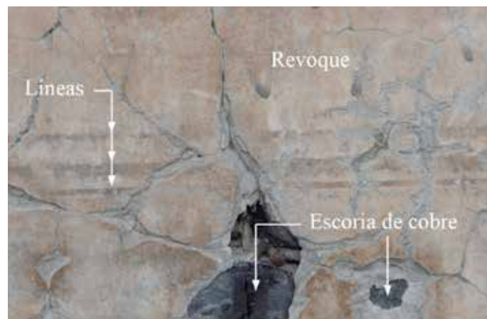
Figura 6: Zona 1: revoque de cemento pintada de color ocre. Se puede observar 3 líneas decorativas más oscuras en el centro y escoria de cobre formando el muro
