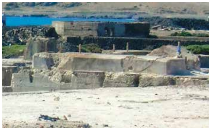
Figura 8: Fundaciones de hormigón en la Zona 3
