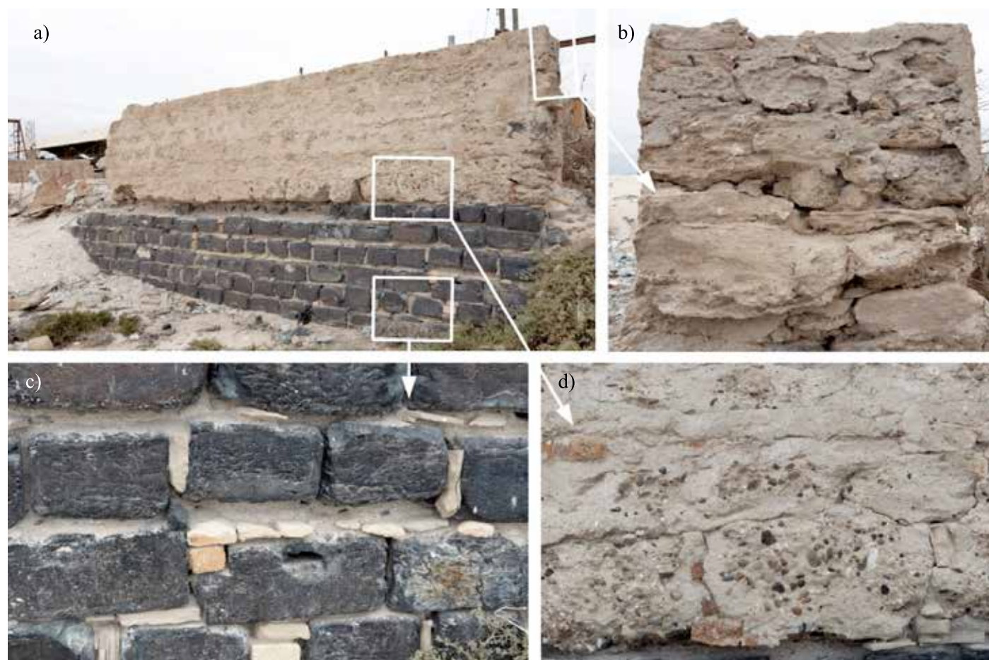
Figura 9: Zona 3. a) Muro de bloques de escoria y tertel, b) trozos de tertel formando el tramo superior del muro, c) bloques de escoria dispuestos alternadamente en tendel y cabeza y d) detalle encuentro de bloque de escoria y tertel.
